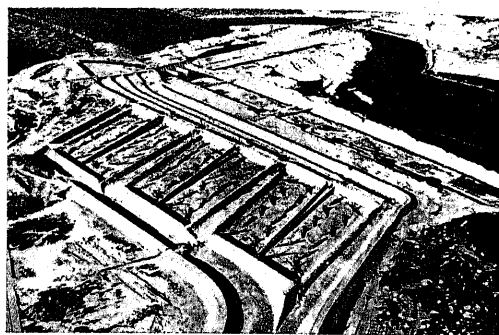
第五百四十二圖 堰堤及土砂排除工事風景
