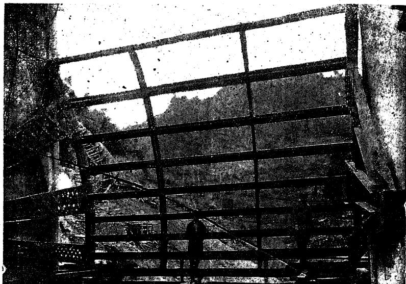
159 圖 A 庄川水力電氣會社 小牧堰 テンマー ゲート（組立作業中）
