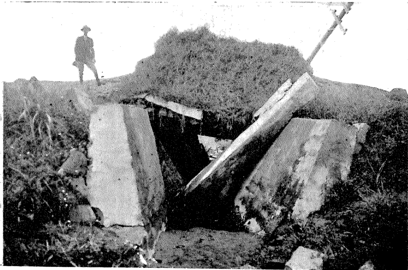
酒匂川西岸國道溝橋の震害、橋臺、コンクリート橋、鐵筋コンクリート裕盛土(5尺)の荷重大なりし爲震害甚し(立てるは著者)
