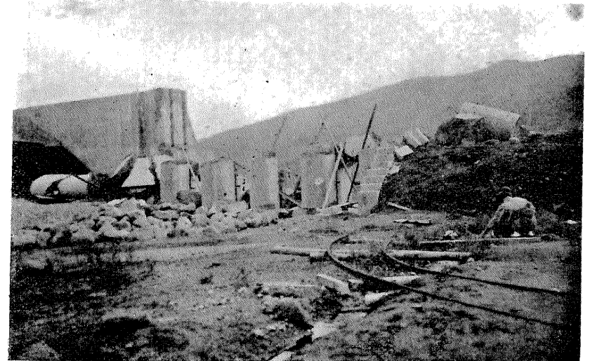
小山附近某發電所調整池水門の震害、震度餘り大ならざりしも 混凝土粗悪なる爲震害著し
