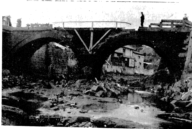
川尻橋（千葉縣安房郡千倉町）の震害、半圓石拱二連全部空積、拱上側面の石積崩壊せしも拱石は餘りゆるまず車馬の通行に耐ゆ（左拱下は著者）
