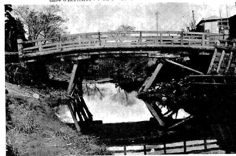
観音橋(横濱市)の震害、地震により兩橋臺は凡て崩壊し橋脚も挫折傾斜す、左方の橋臺は應急假積を爲せる状況
