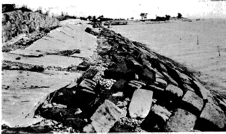
神奈川県横浜郡御幸 村築堤の陥没 (点線は原形を示す)
