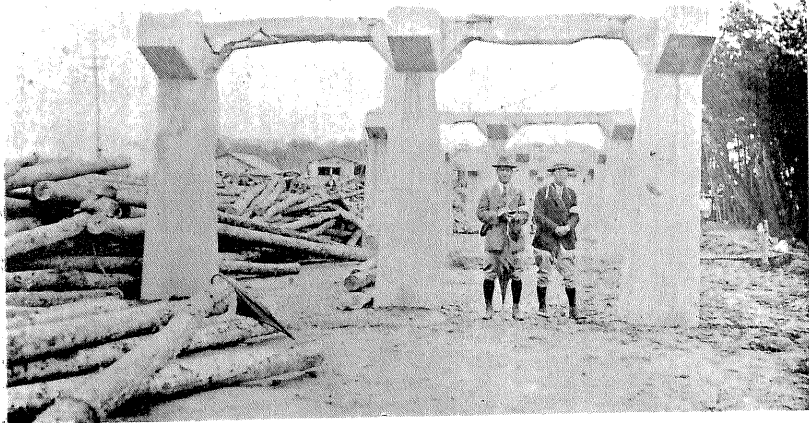
酒匂川西岸國道溝橋の震害、橋臺、コンクリート橋、鐵筋コンクリート裕盛土(5尺)の荷重大なりし爲震害甚し(立てるは著者)
