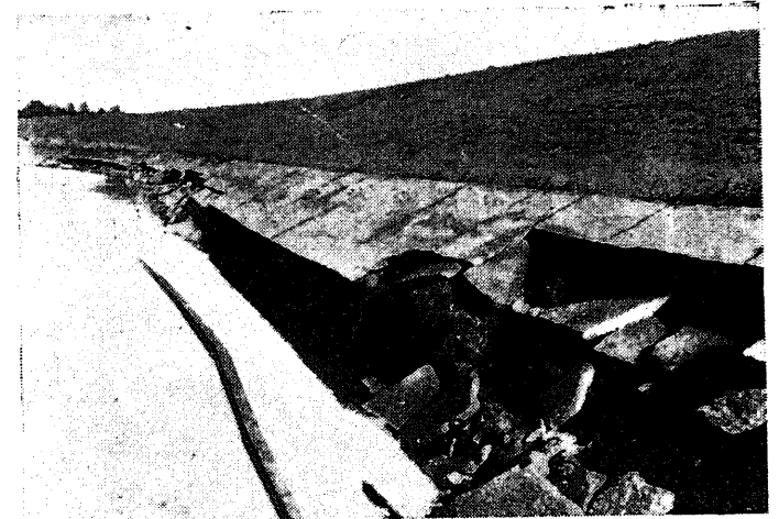
第 97 圖 混泥土護岸の被害
