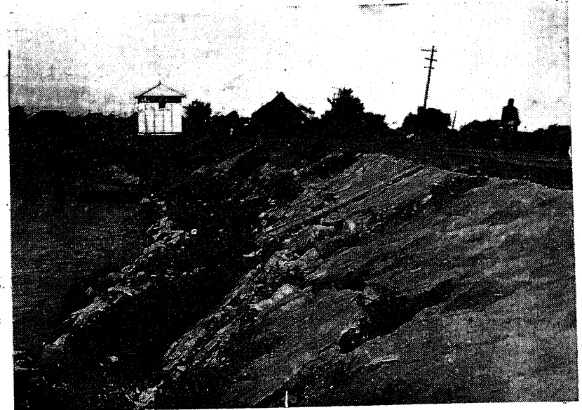
多摩川護岸の滑落
