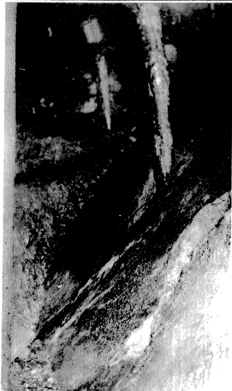
トンネル内で見えた断層鏡面
