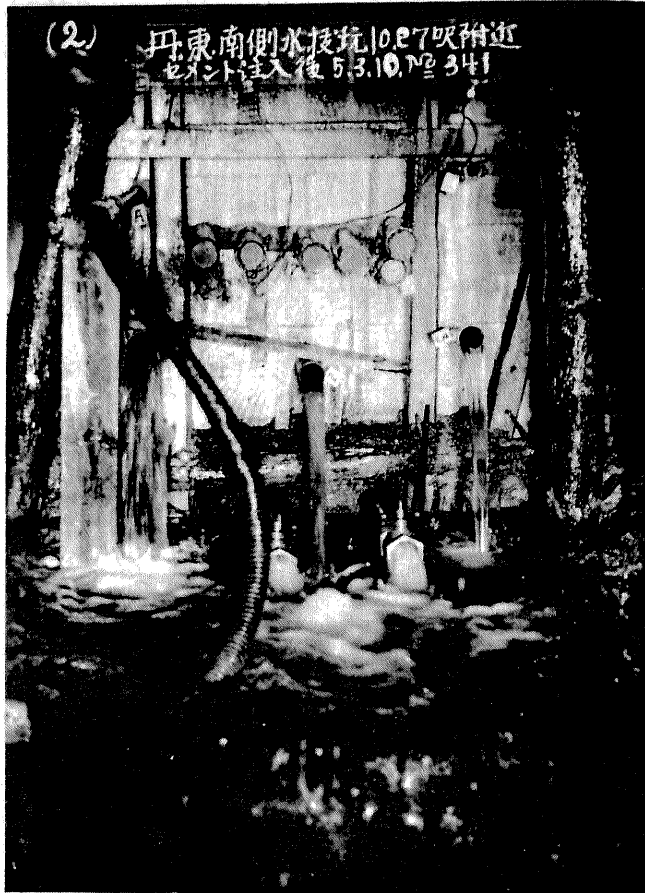
セメント注入用の鉄管を埋めたコンクリート隔壁
