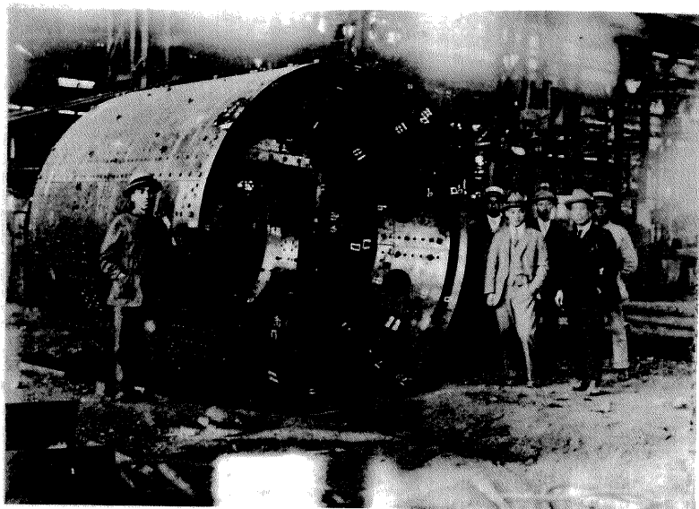
シールド (前面を見たところ)
