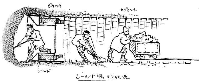
シールド掘削状況
