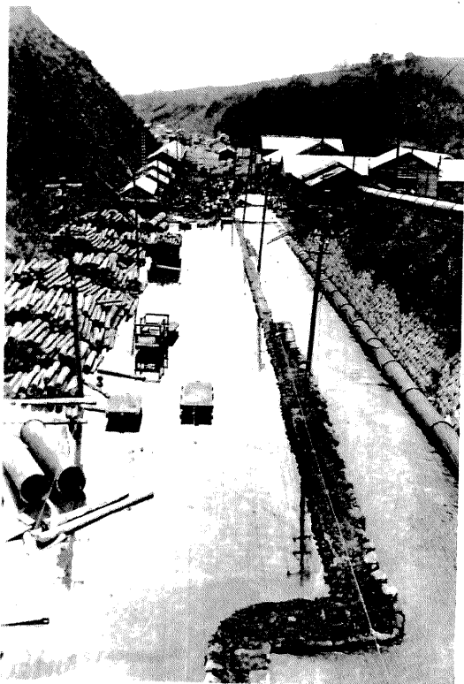
三島口の地下洪水。上は坑内より坑門口を望む、下は坑外の浸水
