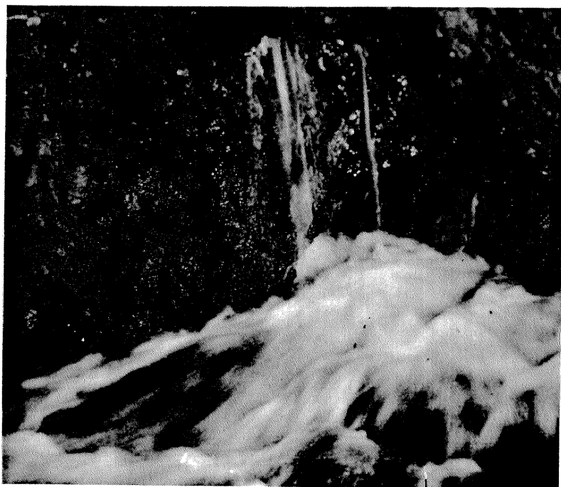
もくもくと噴き出る底設盤の湧水
