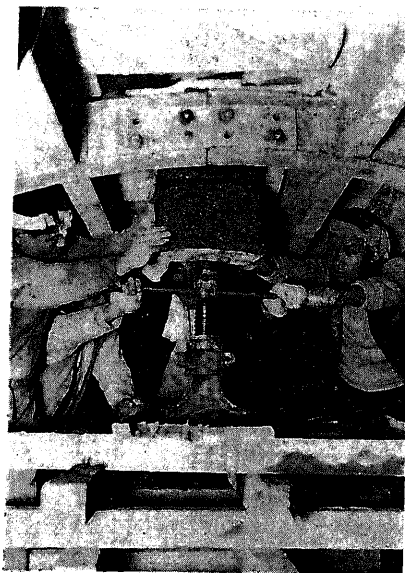
第227圖 石北隧道の上げ迫め
