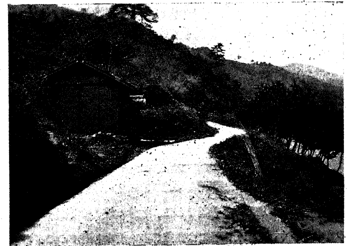
第8圖 八幡濱線 石久保附近海岸 匍行性崩積層 押出された縣道
