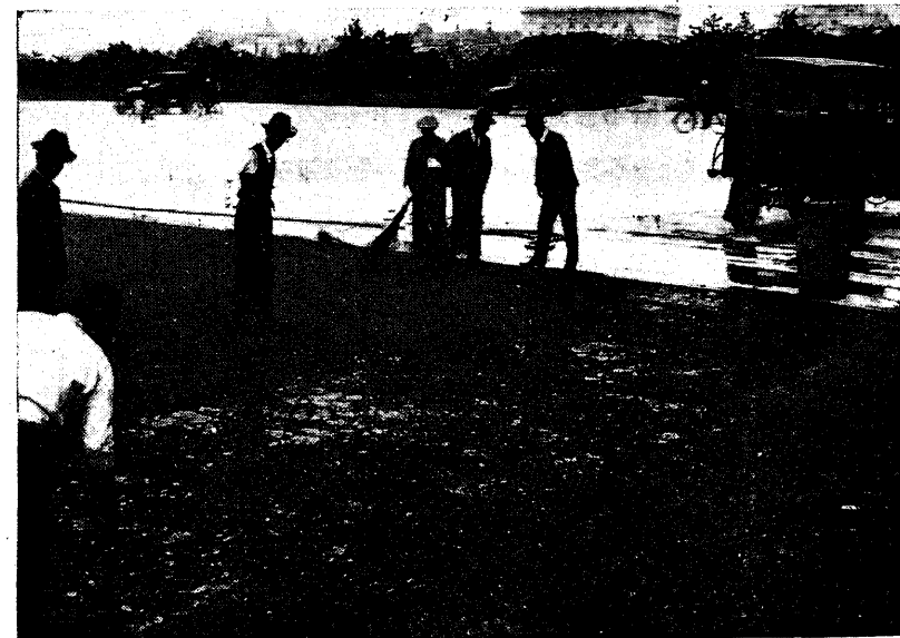
アスファルト・エマルジョンの表面處理(宮城外苑廣場)
