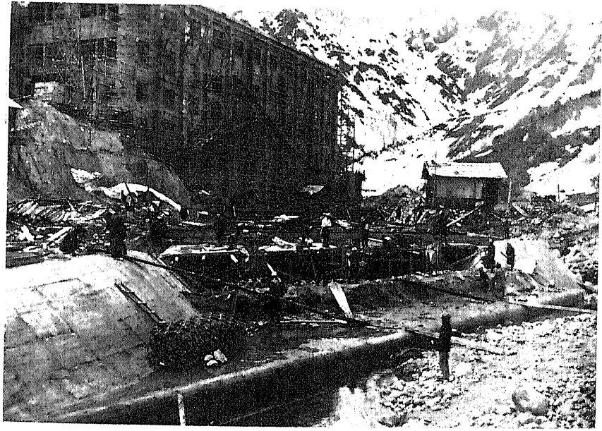
同 B 同 (水路の覆蓋工事中)
