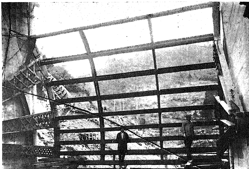
159 圖 A 庄川水力電気會社 小牧堰堤 テンター ゲート (組立作業中)
