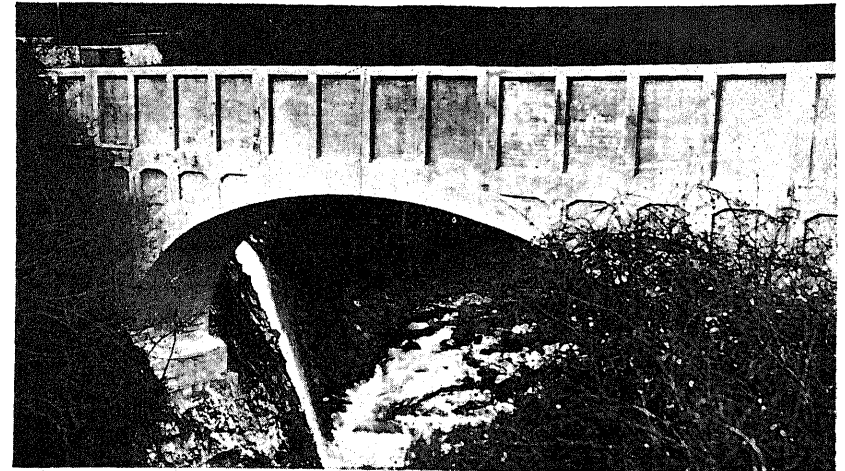
80 圖 A 群馬水電會社 松谷發電所の水路橋
