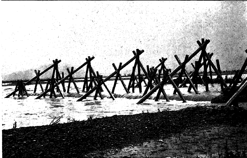
富士川混凝土聖牛水制 (第 221 圖 第 234 圖 參 照)
