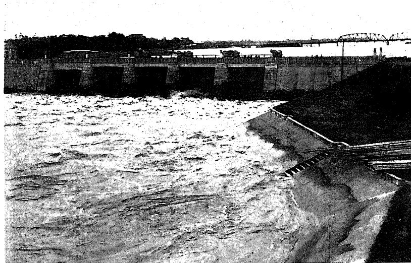
荒川岩淵水門 (第392圖. 第393圖參照)
