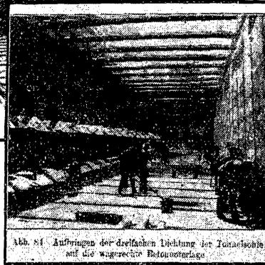
ベルリン路下隧道底部防水工事
