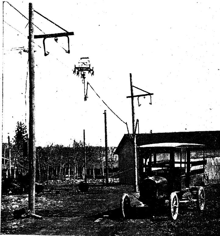
を改造し、之を交流電氣を用ひた無軌條式電車の試運轉の情況である。
