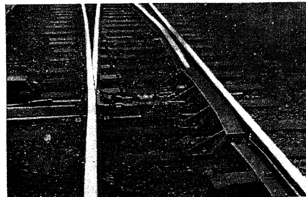
分岐器尖端部防護用護輪裝置
