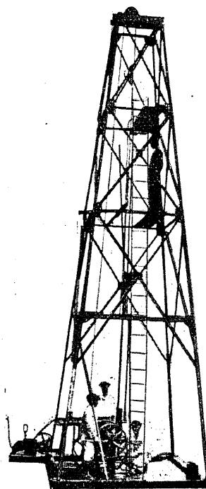
第698圖 鋼鐵製試錐檣
