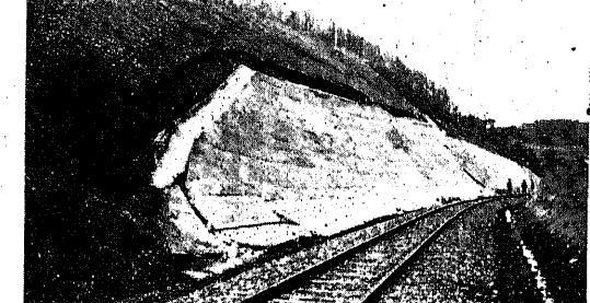
第593圖 八戸線種市・八木間切取の張混凝土の崩壊
