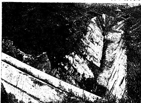
第 584 図 質士身延鐵道勝坂隧道拱門切取壁の倒壊
