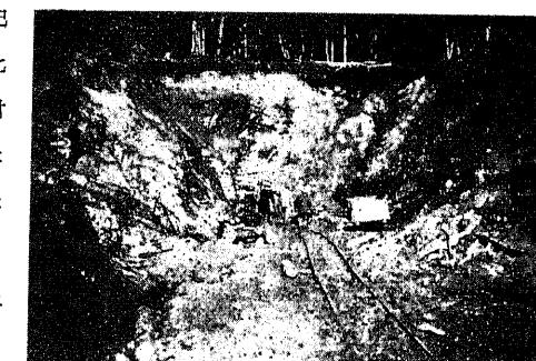
第 585 図 久慈線夏井隧道拱門切取の崩壊
