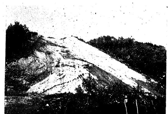
第591圖 八幡濱線切取の崩壊 花崗岩の風化岩質真砂土
