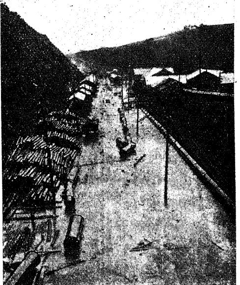
第572圖 丹那隧道西口坑外への湧水氾濫状況
