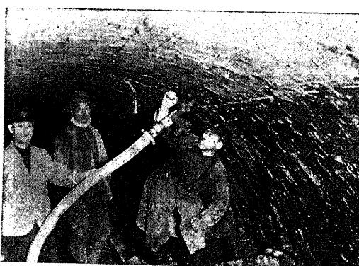
第577圖 (c) 覆工口に挿入せる注入管のノズル
