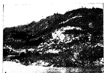
第564圖 a) 岩越線萩野驛の切取の崩壊(大正4年4月)
