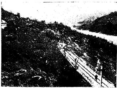
第564圖 b) 岩越線萩野驛の切取の崩壊(大正4年4月)
