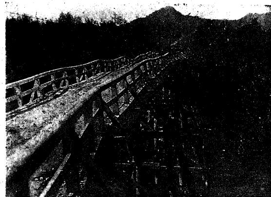
に作用する震力に依て接合部に於て挫折するものあり、特に重量大なる土橋に於ては容易に沈下、傾斜、破折等を起す。
