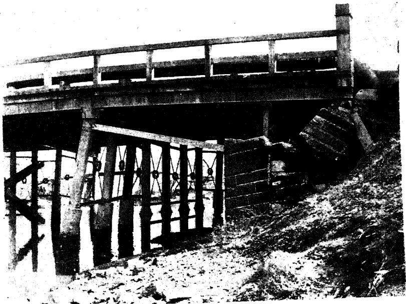
にして、各橋柱を連結せる斜材は多く切斷され橋柱の多くは根本に於て挫折して居る。
