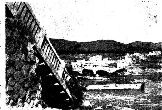
地震力が加増する時は甚しき傾斜推出を爲し易い。第142圖は横濱港の埋立地に架せる萬國橋北岸橋臺の大推出に依り、構端に於て42°の相對移動を爲せるものである。而て橋臺の推出は主桁に大なる壓力を及ぼし、端に於ける鎮鉤が剪断されざる限り構の弦材を彎折せしむる虞れがある。
