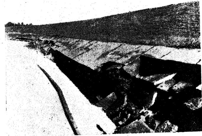
面護岸工の滑出しにして、杭根入の不充分を示し、(b)根入充分にして法下部の孕出したるもの(c)法先地盤の抵抗土壓小なる爲め堤體の著しく推し出されたる場合を意味す。第95圖の震害は(b)又は(c)に屬する。
