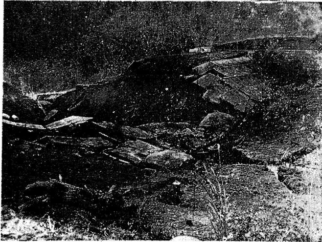
裏法 3 割、堤長約 700 間 基礎 第三紀青色硬粘土、工法 セミハイドロリック、
