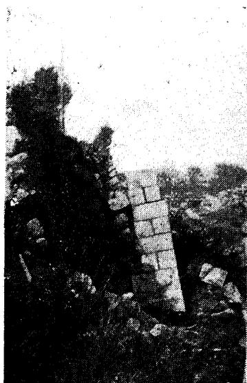
部の抵抗土壓不十分なる爲め數尺押出され、空積なるを以て上部は原位置に止まらんとする爲めの震害であるが、第79圖は其西方突角部にして上部が遂に崩壊せるものである。
