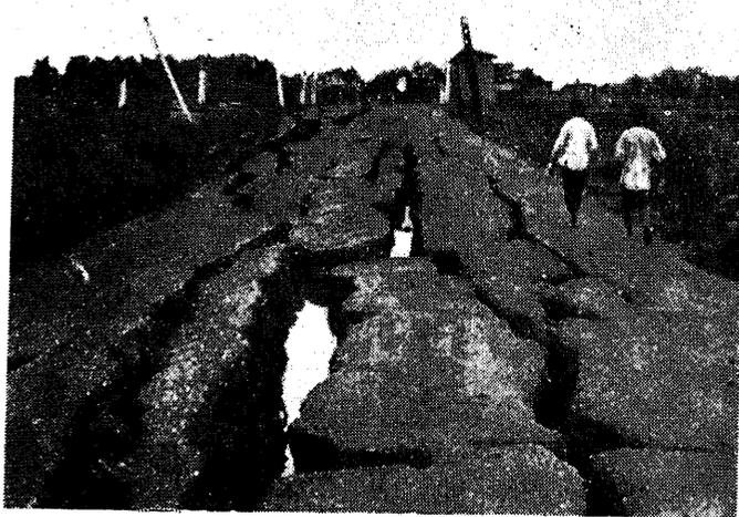
を爲し、S部に龜裂を生ずると共に天端は沈下し突端S'部は崩落し外端T部は押し上げられ地震が繼續するに従ひ、S'部
