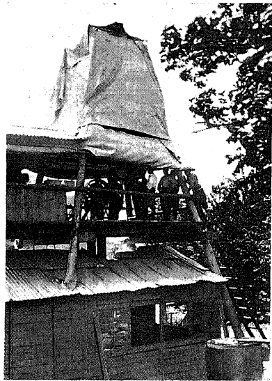
第 466 圖 クレリウス機による 縦ボーリングの状況
