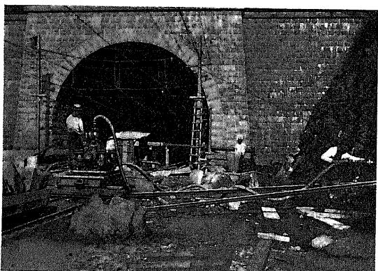
第395圖 小松製氣動式セメント注入ポンプ西口坑前に於ける試運轉
