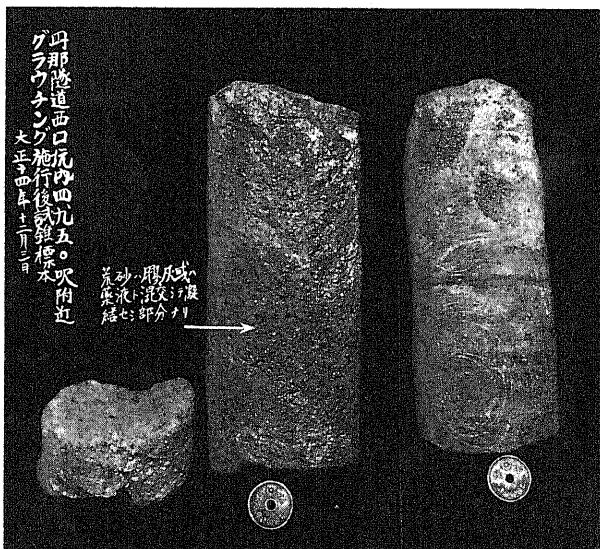
第432圖 膠灰注入を終了して成績調査の試錐を行ひ採取した「コアー」
