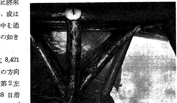
第293図 東口 8,760呎附近 第2左側坑道に於ける坑道の分岐點、土壘は土砂の流出を防ぎたるもの
