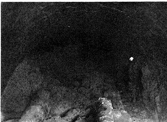
第 289 図 東口 8,800 呪附近 大正 14 年 12 月 30 日第 1 左側坑道より流出した土砂は各坑道を埋めつくした。昭和 2 年 1 月之が取除きを開始して疊築せる底設導坑に達した所
