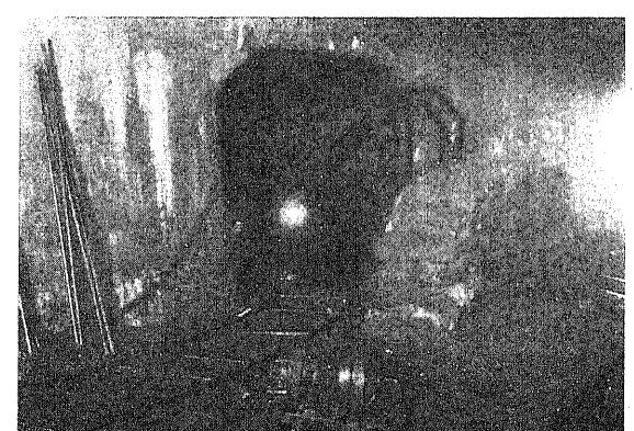
第 283 図 東口 6,600 呎附近 本線より南側水抜坑への連絡坑、大正 14 年 12 月 30 日左側坑道 9,000 呎附近に發生した湧水事故による流出土砂の防禦工事に用ふる土袋
