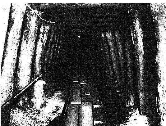
第275図 東口 8,520呪附近底設導坑支保工の補強
