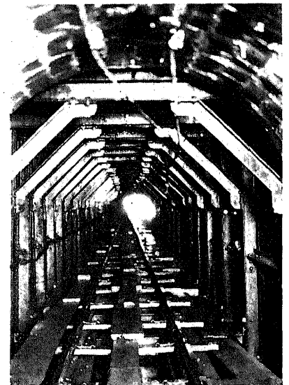
第 272 圖 西口 4,950 呎附近第二副坑道
