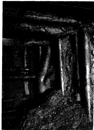
第 262 圖 西口 4,950 呎附近底設導坑掘鑿に際し 6 吋鐵管を柱として使用したが土壓の爲め折損せられた。
