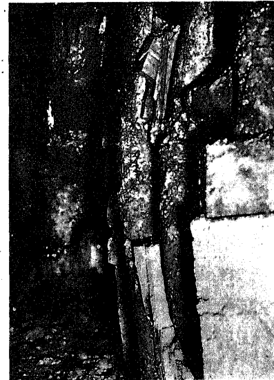
第 273 圖 西口 4,950 呎附近斷層箇所底設導坑 (中央曲れる 2 本は鐵柱)
