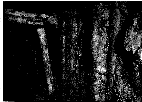
第 266 圖 西口 4,950 呎斷層箇所埋没せる底設導坑支保工(右側の導坑柱は鐵柱なり)
