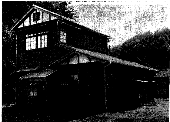
第 259 圖 空氣掘鑿の際設置せる東口救護室 「ホスピタルロック」を設置す
