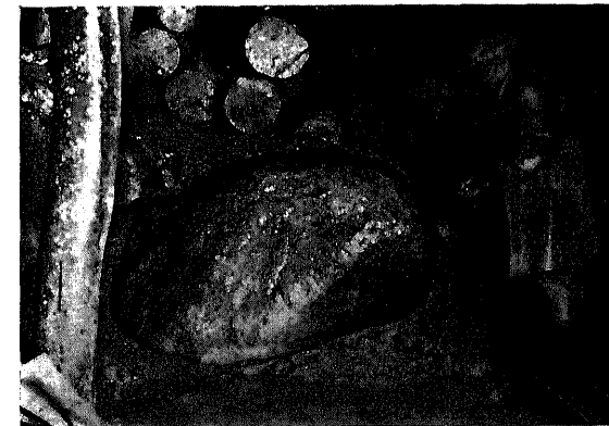
第254圖 西口底設導坑5,000尺附近崩壊箇所奥端にあつた大岩石
