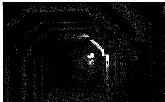
第204圖 東口底設右側迂廻坑 8,900 呎附近鐵製支保工
