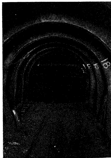
第205圖 鐵製支保工構築狀況(馬蹄形)
