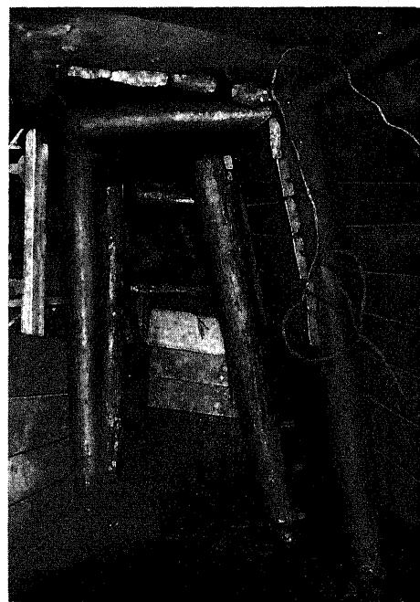
第189圖 東口底設導坑10,270呎附近縫地工法
