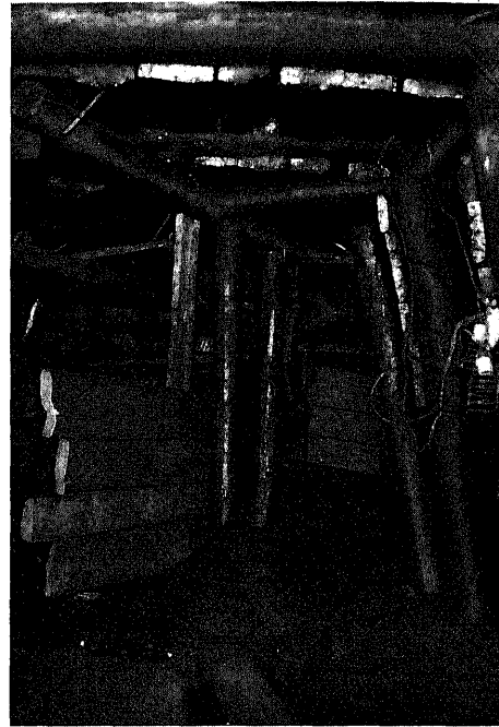
第190圖 東口底設導坑 10,270 呎附近縫地工法
