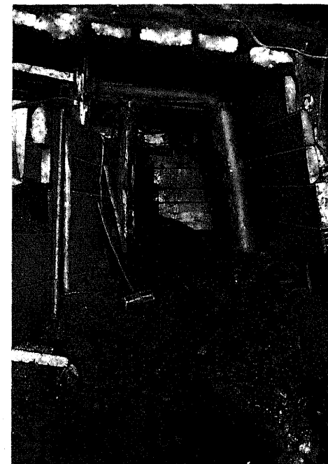
第188圖 東口底設導坑10,270呎附近縫地工法
