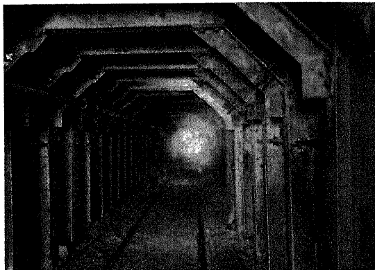
第174圖(B) 東口底設右側迂迴坑 8,900 呎附近鐵製支保構
