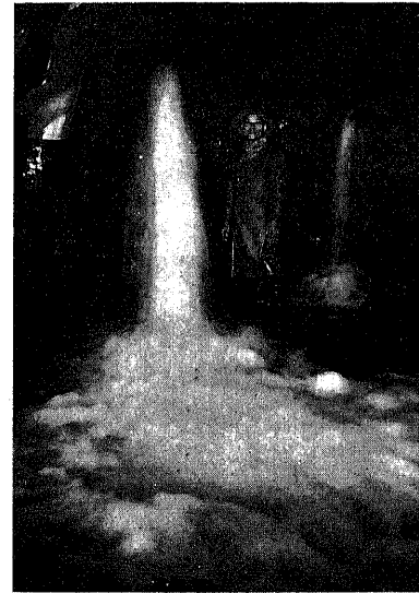
第75圖 東口底設導坑 9,180 呎附近に於ける試錐孔よりの湧水状態
