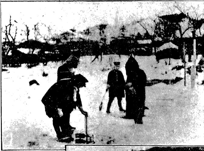
吊籠測水作業
