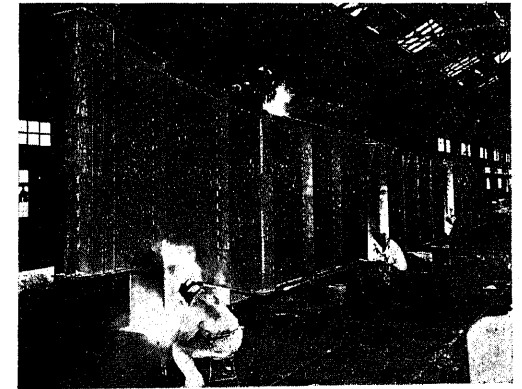
第295圖 主桁鋸接中の圖
