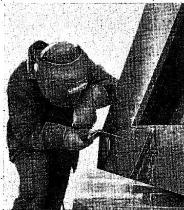
第231圖 銲接作業中の銲接工
