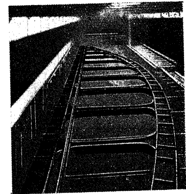
第 218 圖 工場銲接中の Schooten Nr. 40 橋
