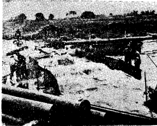
圖—8, 吸場唧筒による 浚深工事 Print Ab 8.
