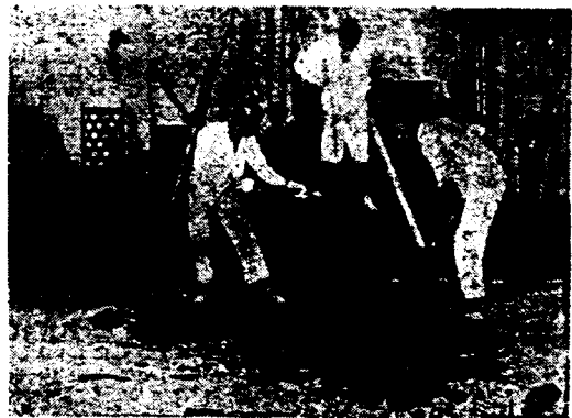
第10圖 混凝土摺固
