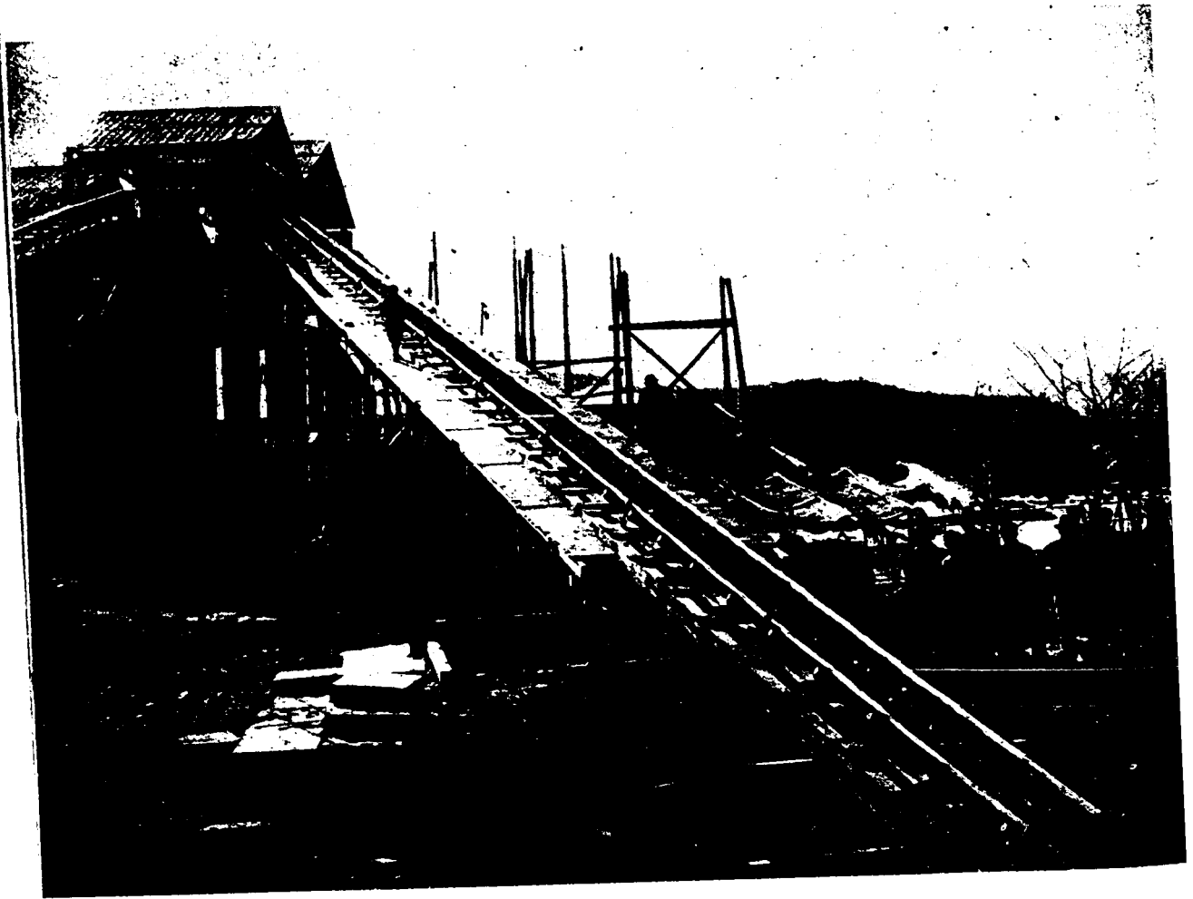
混合工場ベルトコンベヤー運轉狀況
