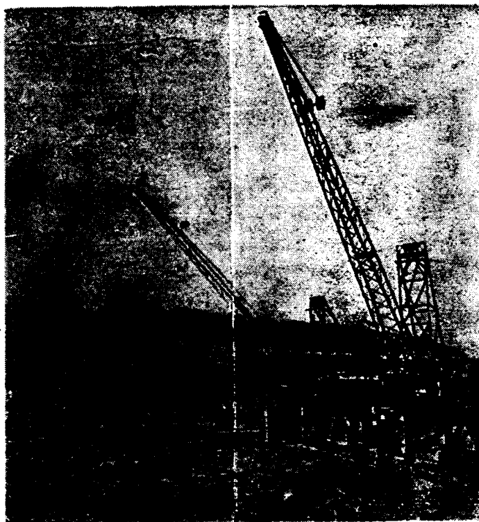
松花江發電チブクレーン活動狀況
