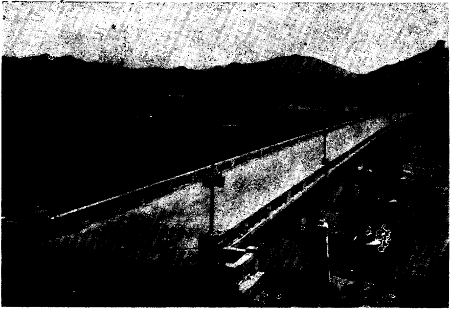
竣功セル本溪大橋
