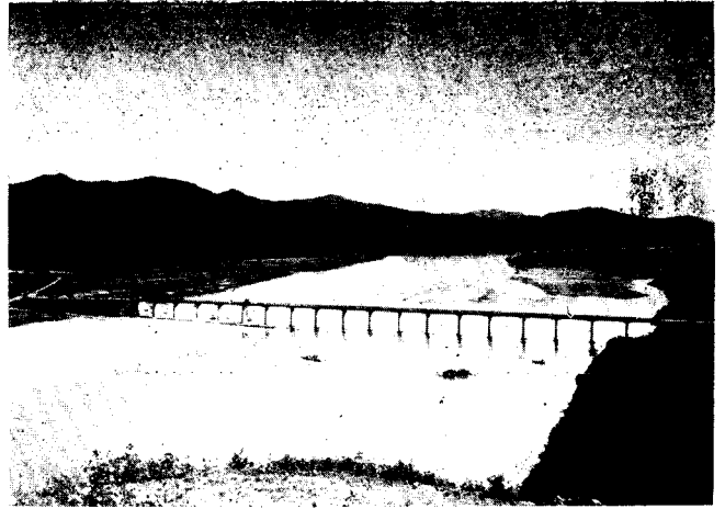
↑ 竣工ノ全景(安東側上流高所ヨリ下流ヲ望ム)
