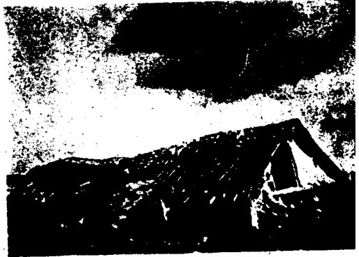
寫眞8 頂巖子の民家、この中に砂水噴出口3ヶ所あり。土杯子造りの構造に注意
