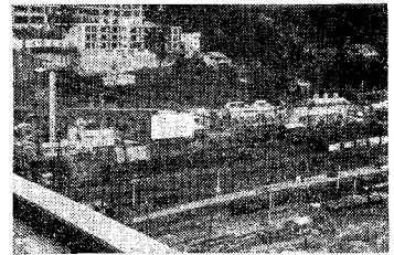
新丹那トンネル坑外設備
