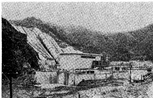
同ダムは電源開発KKが総工費414億円を投じ、庄川上流の岐阜県大野郡白川村に去る32年6月以来建設中のものであり高さ131m、体積795万m<sup>3</sup>という超大型なもので、満水位標高860m、湛水面積8.8km<sup>2</sup>、利用水深65m、有効貯水量は3.3億m<sup>3</sup>である。
