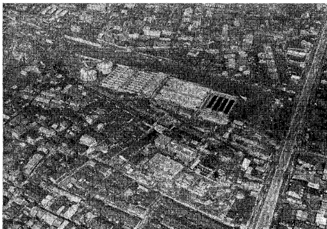
写真一1 中浜下水処理場(工事中)
