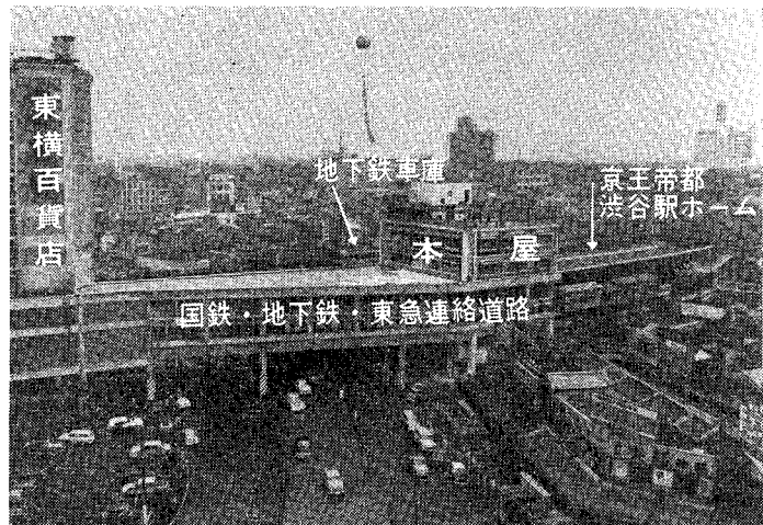
改良工事を終つた渋谷駅
