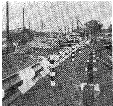
写真-1 実験-4 におけるガードレール実験場全景
