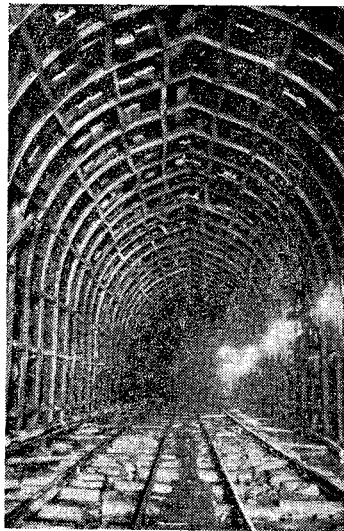
写真-2 逢神坂トンネルのレール支保工
