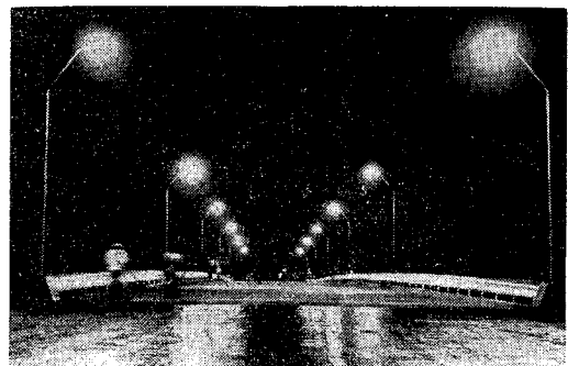
【写真提供：山口県土木建築部】
