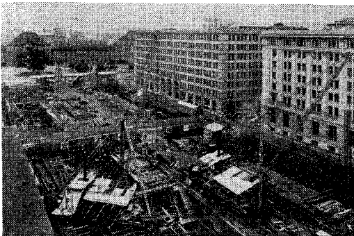
工事中の状況 (34.7.14)
