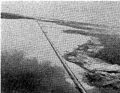
写真-2 西部干拓堤防(昭.33.12月干陸直前)
